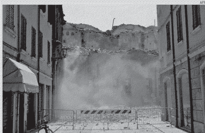
I crolli. La polvere provocata dal crollo di un palazzo a Mirandola
